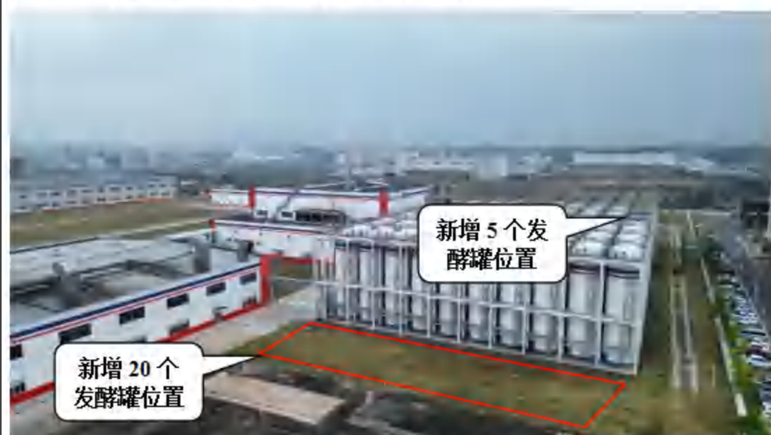
图 4 发酵罐区现场照片
